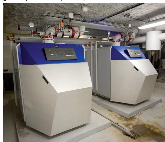
Deux chaudières gaz à condensation et à brûleur modulant Atlantic Guillot de 980 kW produisent la chaleur pour la mise en température des bassins et l'alimentation de la pompe à chaleur à cycle à absorption.
