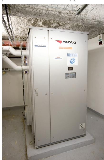
La pompe à chaleur Yazaki de 70 kW froid. Son bouilleur reçoit une eau à 88 °C et produit par échange thermique une eau glacée à 7 °C et une eau chaude de rejet de 35 °C. Ces deux flux sont exploités dans les centrales de traitement d'air de déshumidification et chauffage du hall des bassins.
