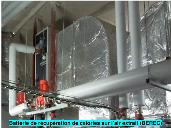
Batterie de récupération de calories sur l'air extrait (BEREC)
