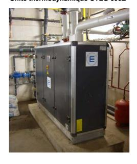
Régulation fonction de l'humidité spécifique à la reprise, agissant en séquence, en tout ou rien sur l'U.T, et progressivement sur les volets de mélange air neufair repris (C.T.A modulation), apportant la quantité d'air neuf adéquat aux besoins des locaux traités, complétée par un thermostat de protection contre le gel des batteries et le contrôle de colmatage des filtres à air par des pressostats différentiels.
