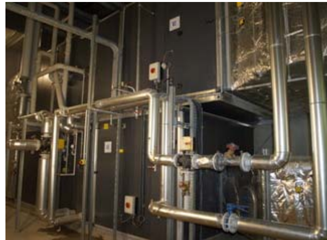
Deux Systèmes de traitement d'air ECO DAD 101 Basique 4
