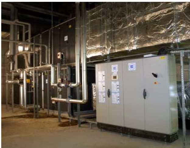
Groupes de production d'eau glacée et eau chaude à absorption
