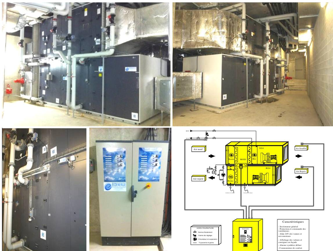
Ces systèmes assurent l'apport d'air neuf hygiénique et la déshumidification des halls bassins en tenant compte de l'évaporation du plan d'eau tranquille, l'entraînement d'eau sur le corps des baigneurs et de la vapeur d'eau provenant de la respiration des occupants.
