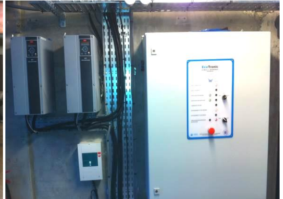
Variateurs + Armoire de commande et de régulation « ECOTRONIC » pour le système MAN+
