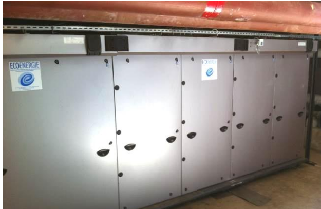
CTA à modulation d'air neuf (MAN+) avec récupérateur enthalpique équilibré (débit variable : 24 000 m 3 /h max)
