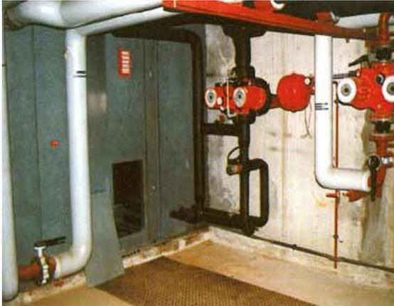
Intégration du caisson de déshumidification DUTr dans le caisson existant de la centrale.
