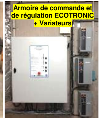
Section déshu thermodynamique (THERMO) Débit fixe : 2 350 m 3 /h
