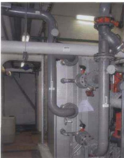
> Le groupe à absorption fourni par Climgazpro est de type indirect eau chaude avec un couple eau / bromure de lithium, de marque Yazaki modèle WFC SC20.
