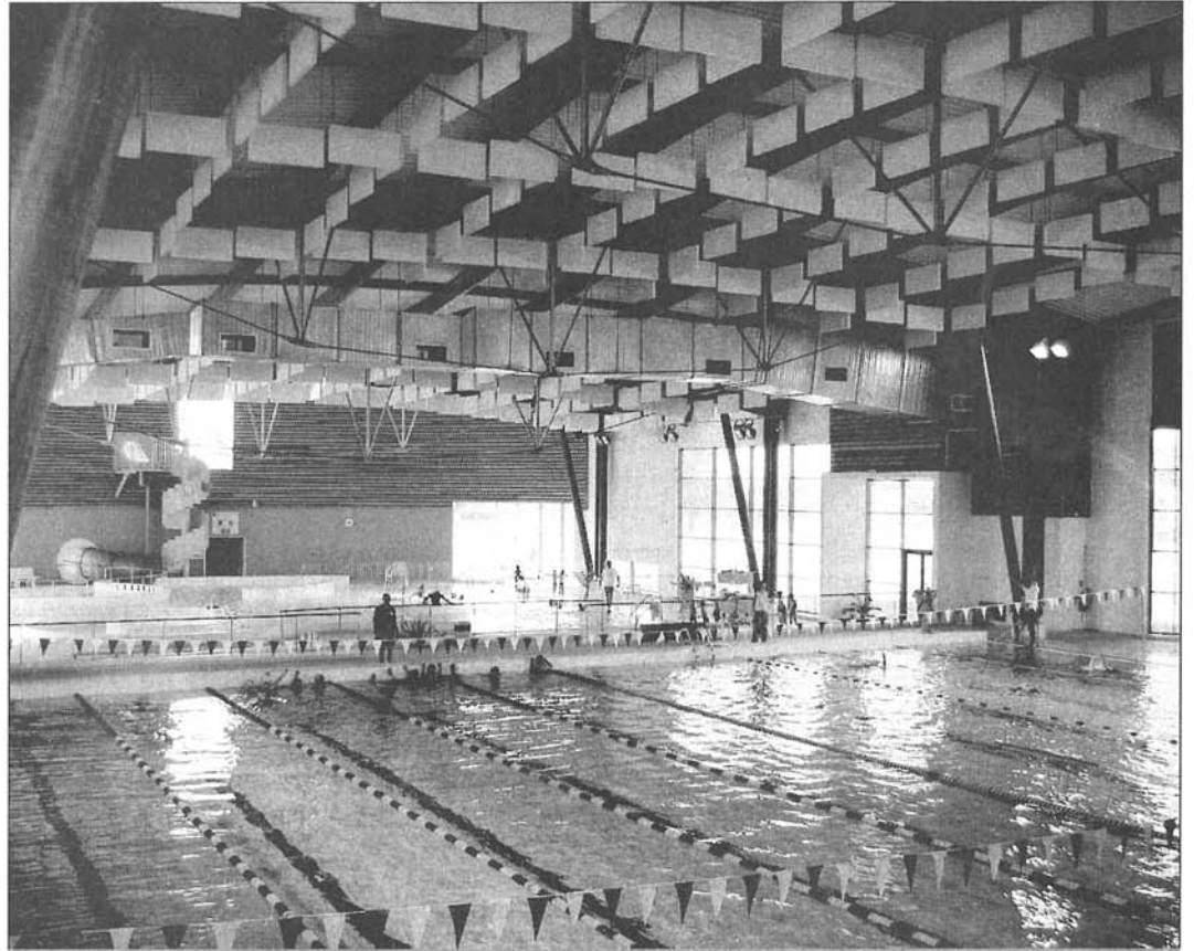
► L'intérieur de la toute nouvelle piscine d'Alès est équipée du système qui utilise les techniques de traitement de l'eau, de l'air et de gestion des énergies. / PHOTO A.L.
